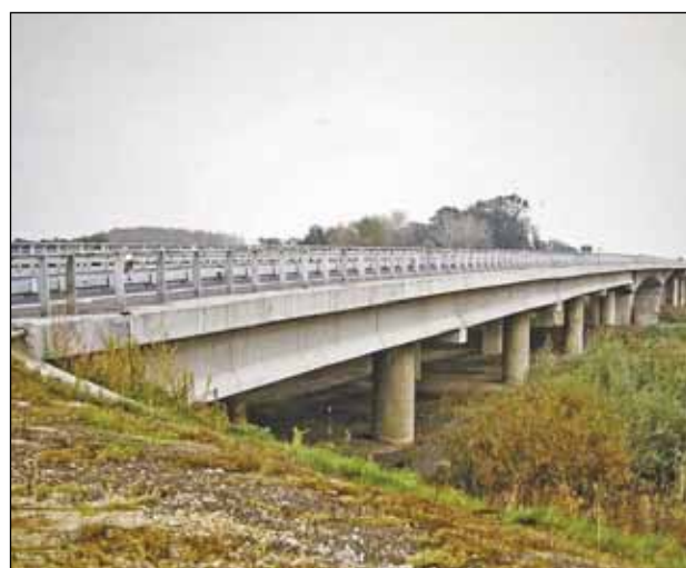
Propojení české a slovenské dálnice D 2 mostem přes řeku Moravu v r. 1980
