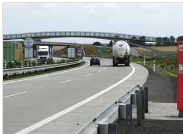
1. etapa stavby R 35 Křelov – Slavonín
