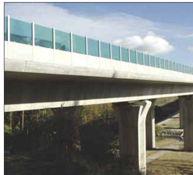
Protihluková clona na mostě D 5 u Plzně
