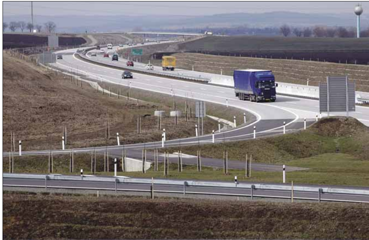
Dálnice D 1 v úseku Vyškov – Kojetín
