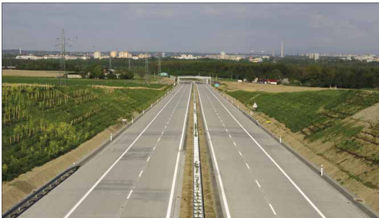
Dálnice D 1 (dříve 47) napojující Ostravu
