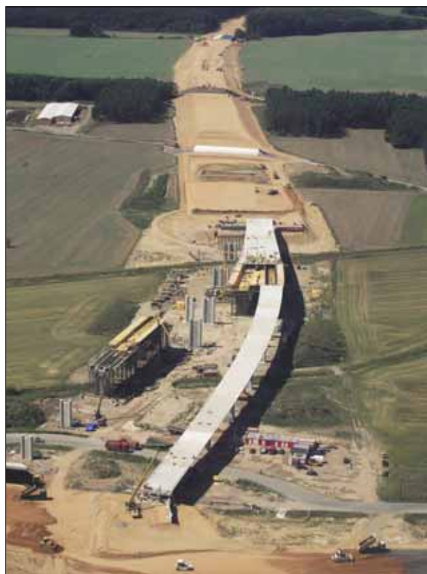
Stavba R 35 v úseku Sedlice (D 11) – Opatovice
