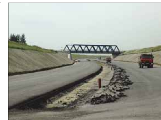
Stavba rychlostní silnice R 6 v úseku Praha – Pavlov
