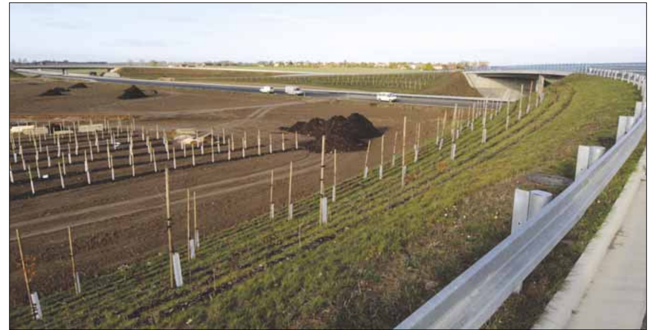
Výsadba vegetace v křižovatce D 11 u Sedlic
