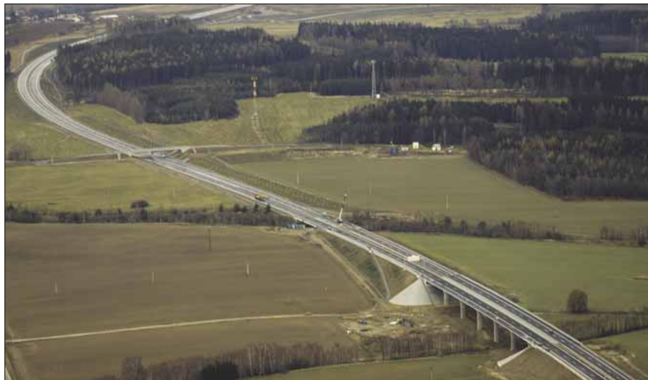
Stavba dálnice D 3 v úseku Mezno – Chotoviny
