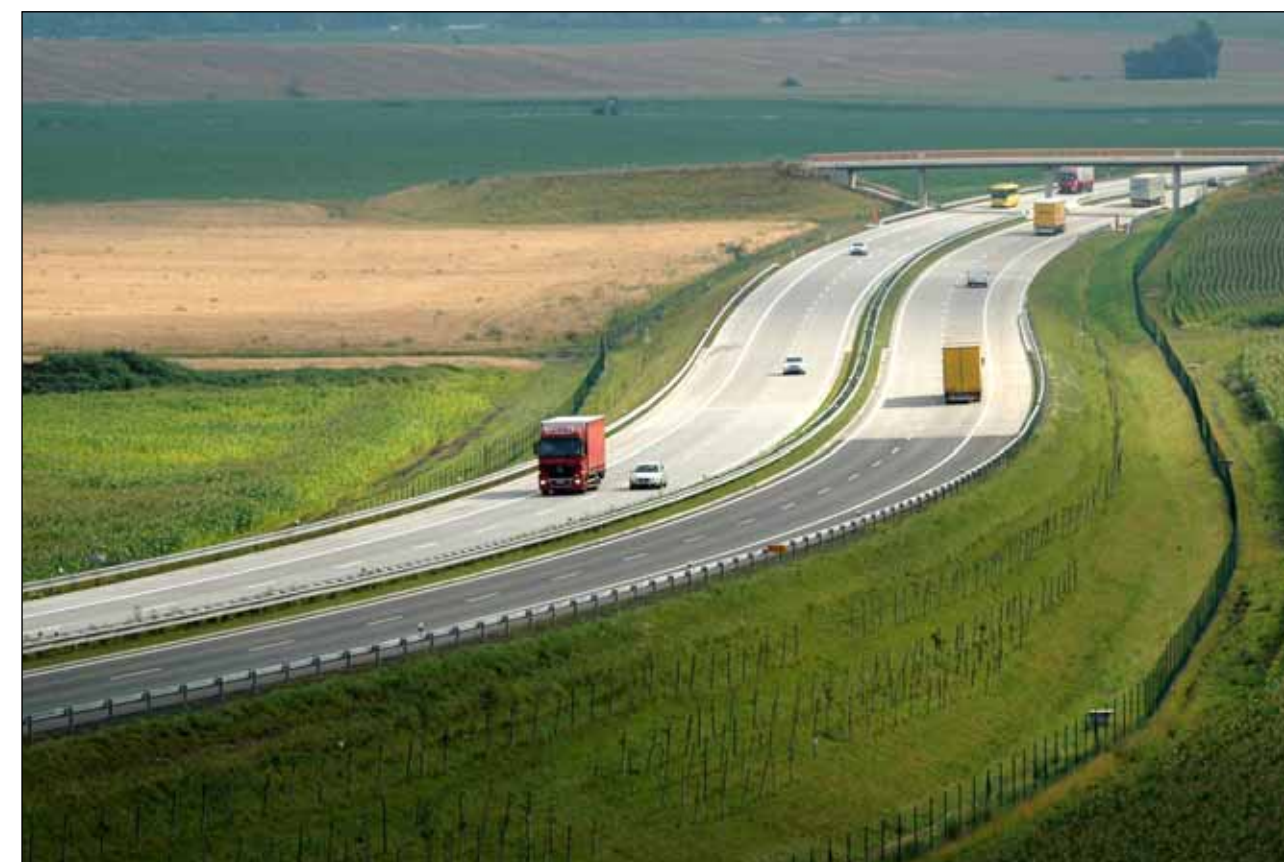
Dálnice D 11 v úseku Libice n. Cidlinou – Chýšť
