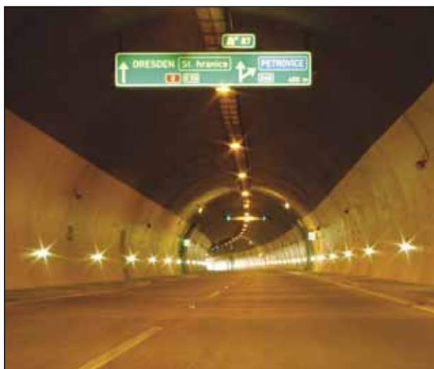
Tunel Panenská na dálnici D 8
