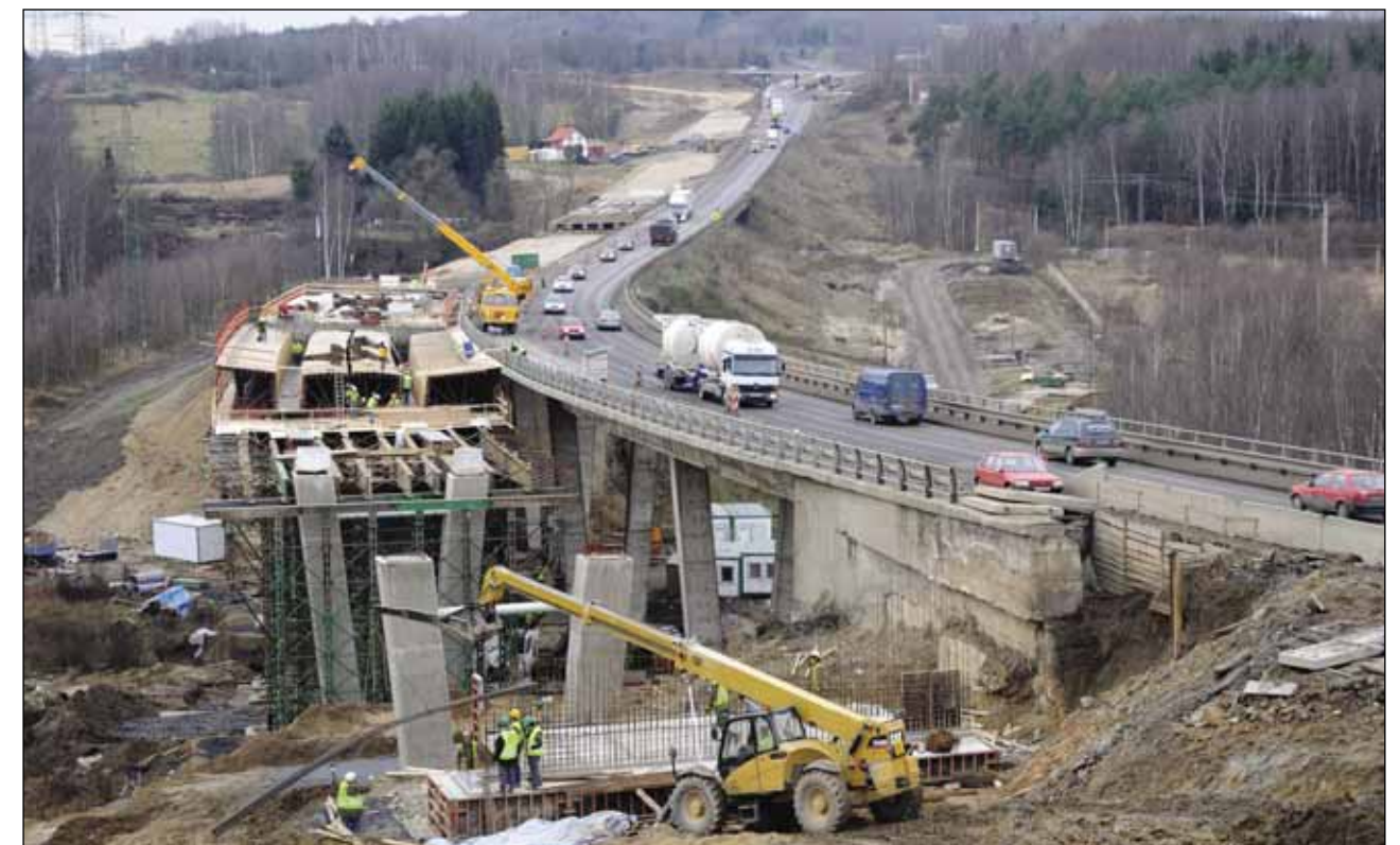
Rozšíření silnice I/6 na rychlostní silnici R 6 u Tisové
