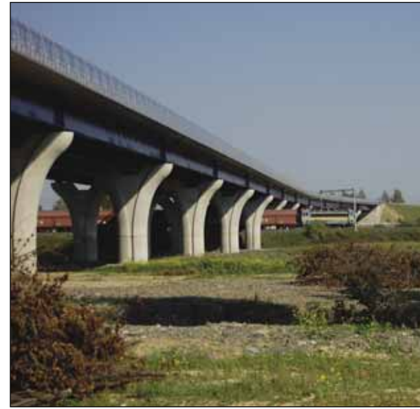
Most na rychlostní silnici R 48 u Běloutína
