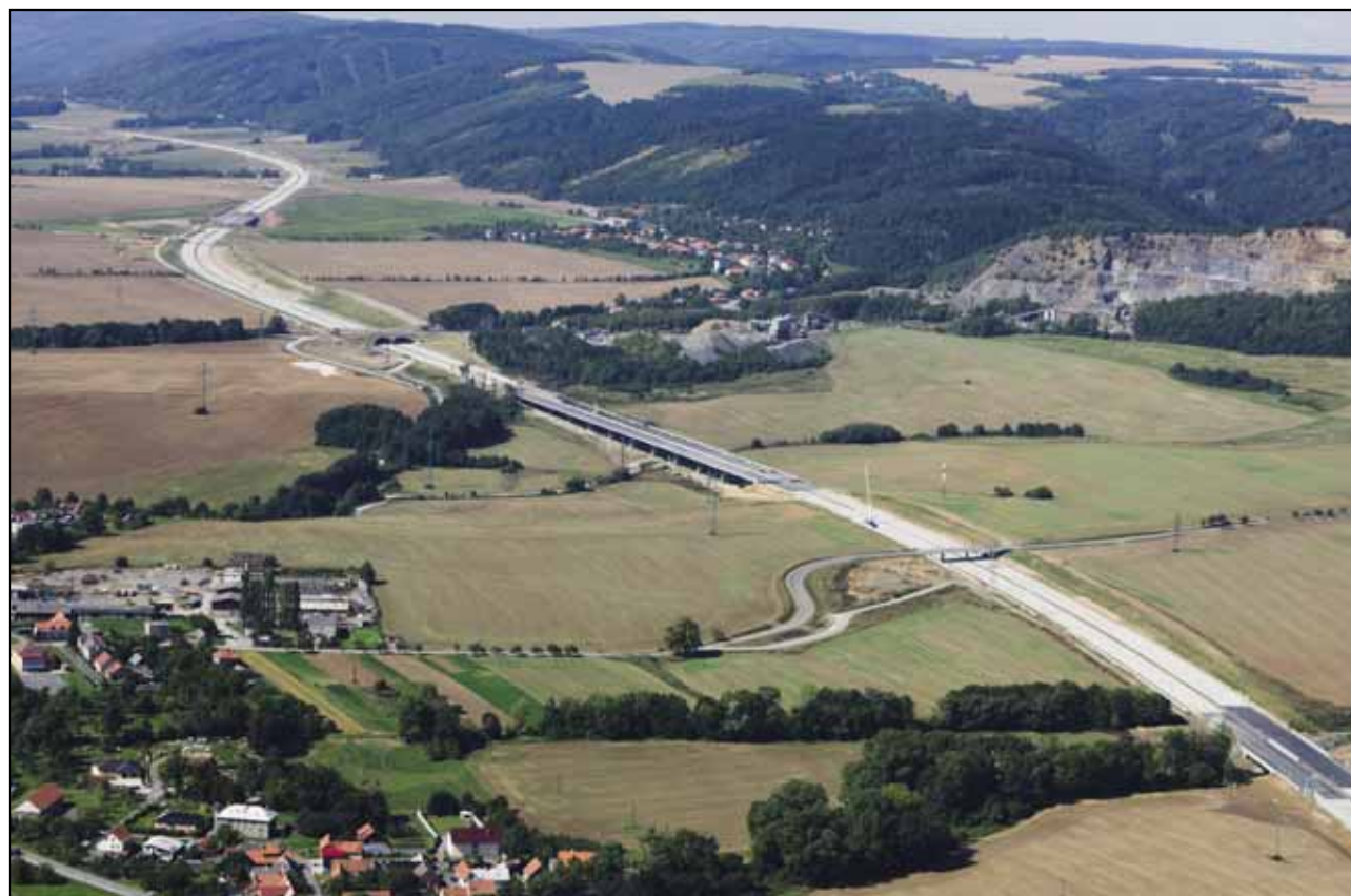
Stavba dálnice D 1 (D 47) v úseku Lipník nad Bečvou – Běloutín
