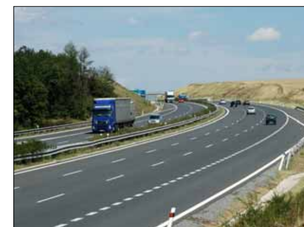
Poslední dokončený úsek dálnice D 5 na obchvatu Plzně
