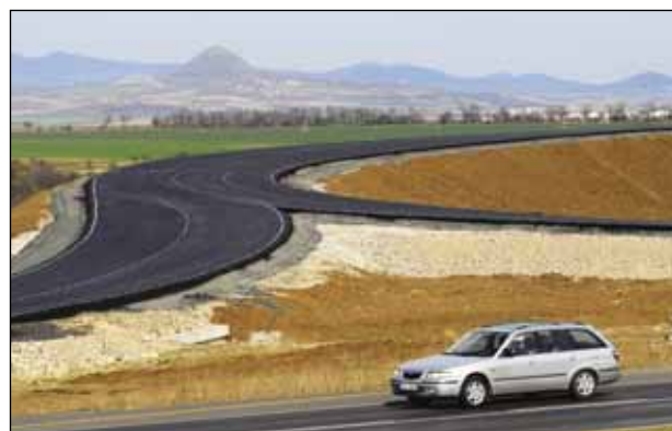
Stavba mimoúrovňové křižovatky Vysočany na R 7
