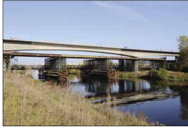
Stavba mostu SOKP přes Berounku
