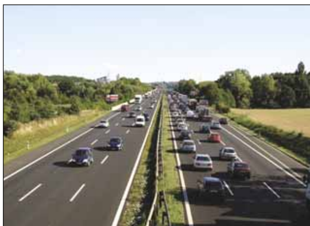
Hustý provoz na dálnici D 1
