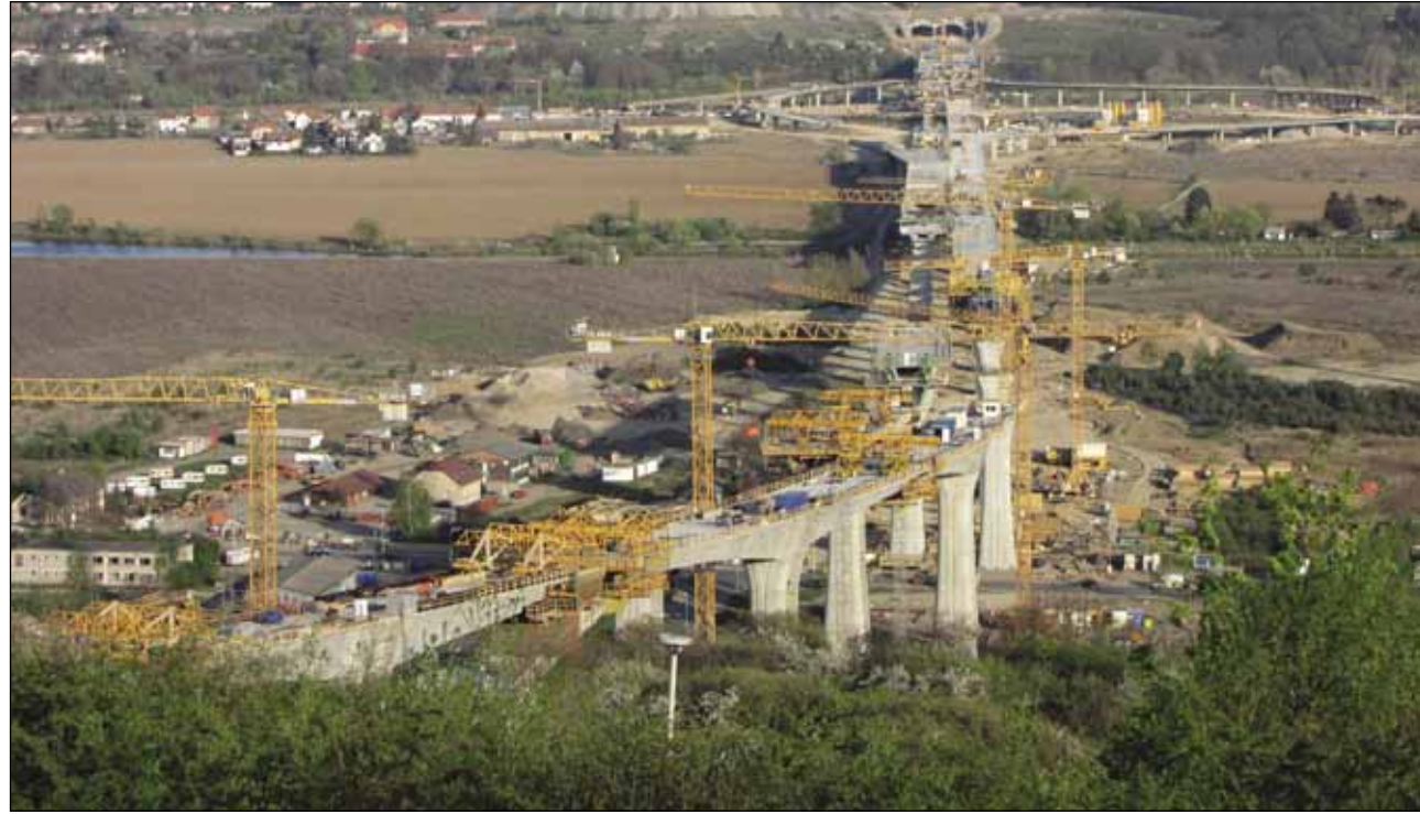
Stavba SOKP přes údolí Vltavy a Berounky
