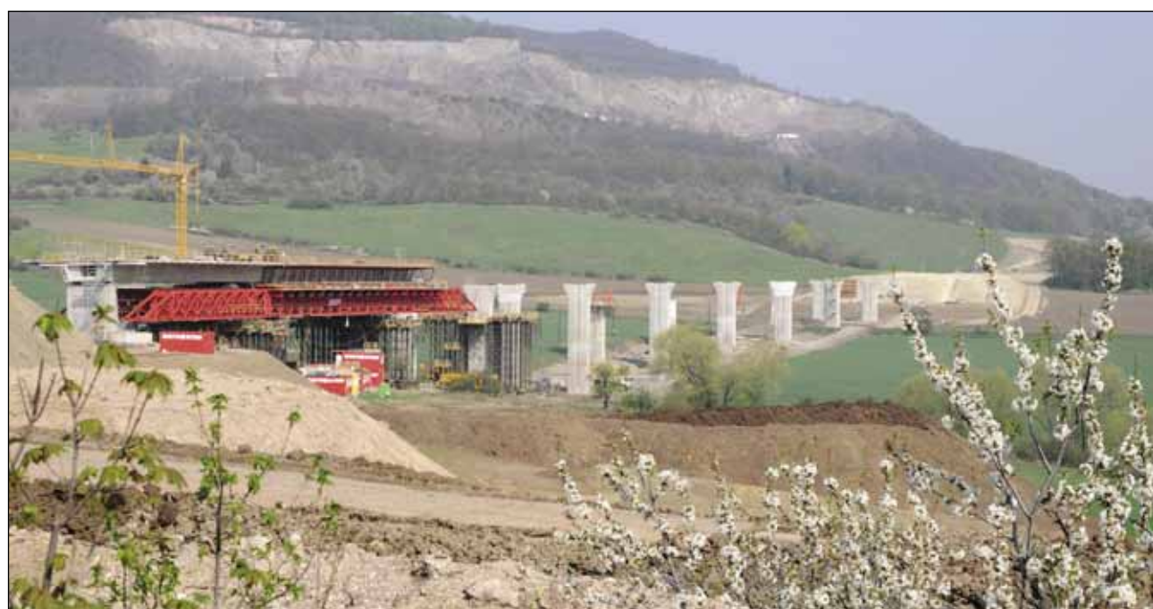
Stavba dálnice D 8 v úseku Lovosice – Řehlovice
