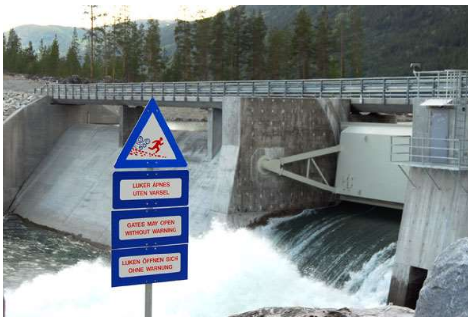
Obr. 2 Drobná vodní nádrž s elektrárnou poblíž lokality Dønfos na řece Otta.
