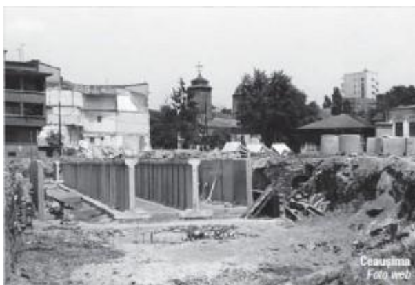
Obr.50 Stavba Lidového paláce (Bukurešť)
