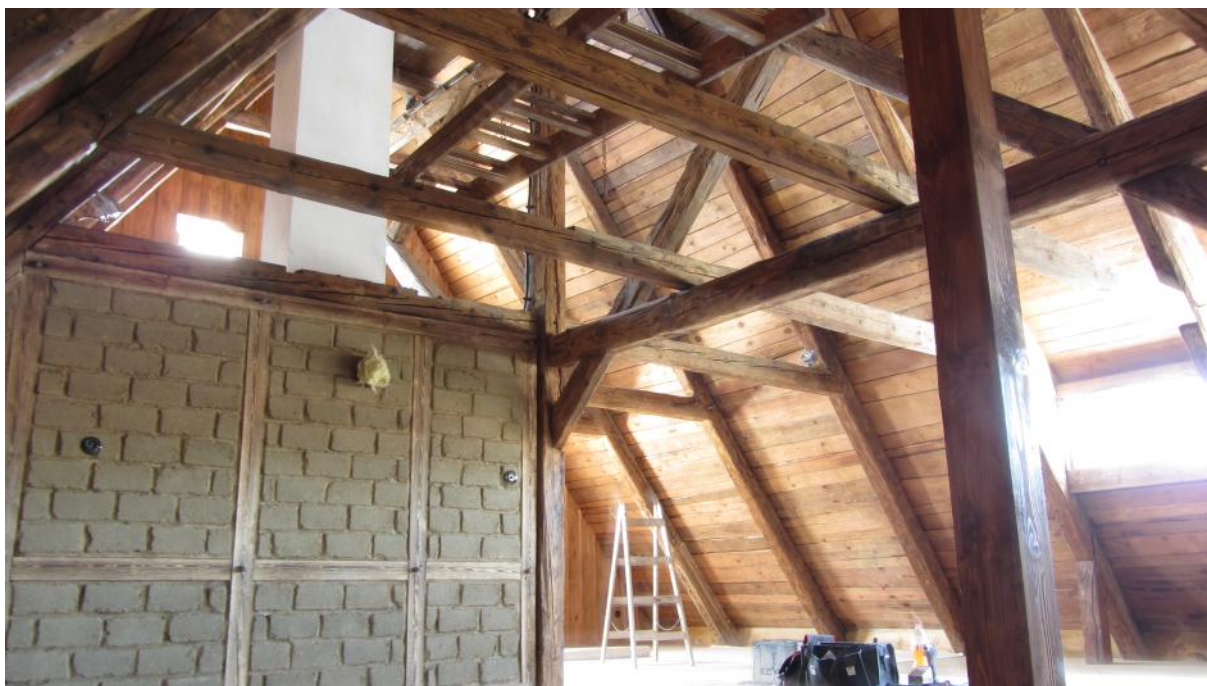
Obr. 28: Podkroví podstávkového domku, který je rekonstruován za pomoci MAS Šluknovsko (foto: F. Chvátal).
