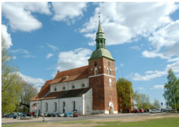
Obr. 68 Kostel sv. Simona ve Valmieře
